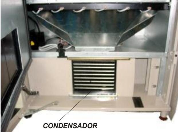
En el condensador se deposita polvo y suciedad como consecuencia del aire de refrigeración que lo atraviesa, impulsado por el ventilador.
